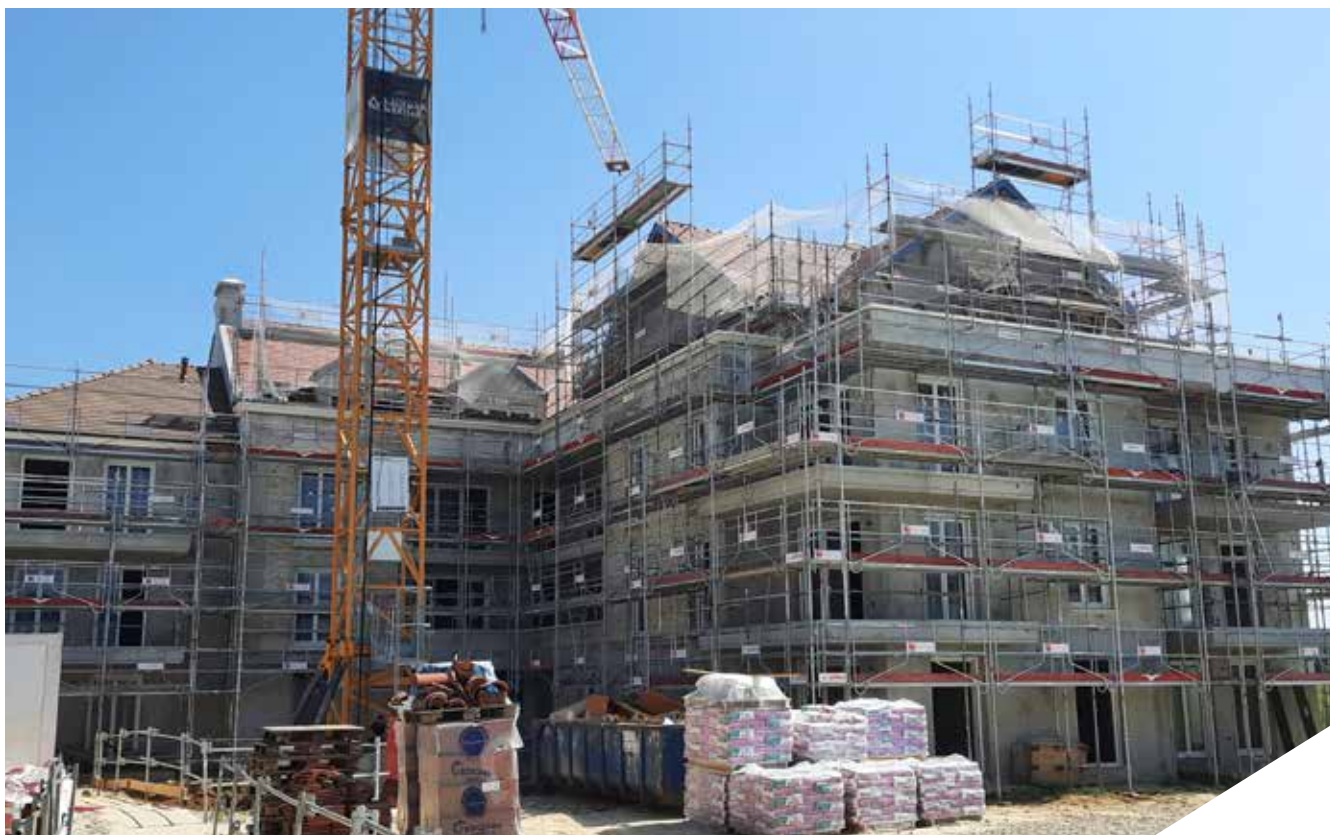
Résidence Écho, conçue par Synthèse Architecture et réalisée par Kaufman & Broad et Sully Immobilier, en cours de construction, Saint-Pierre-du-Perray (91).
