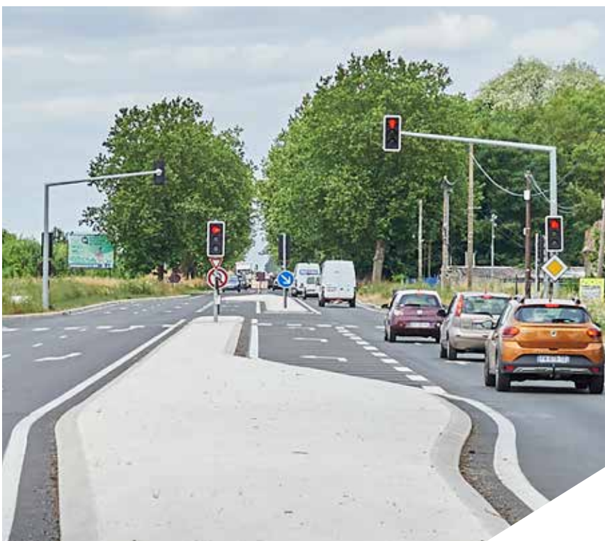
Écoquartier du Balory, Carrefour à feux de la RD306, Vert-Saint-Denis (77).
