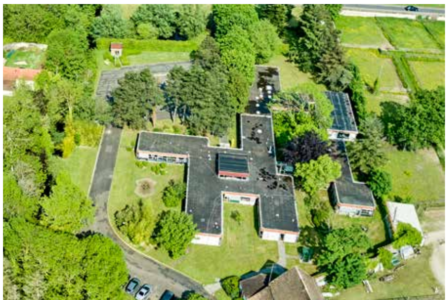
Ancien site de l'EPA Sénart, La Grange-La-Prévôté, Saigny-le-Temple (77).
