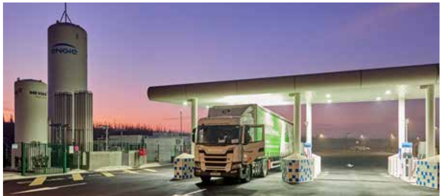
Station d'avitaillement multi-énergies, Parc de l'A5-Sénart, Réau (77).
