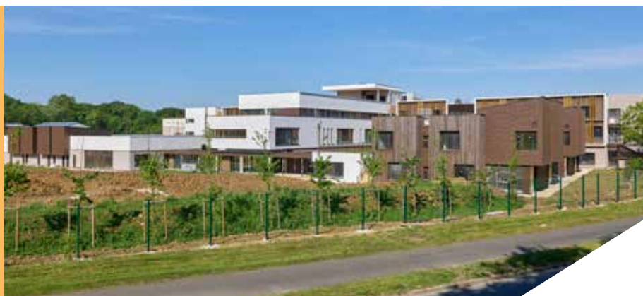
Établissement « Maisons hospitalières » de Sénart de l'association Les Ailes Déployées en cours de construction, Parc de Villebouvet, Savigny-le-Temple (77).
