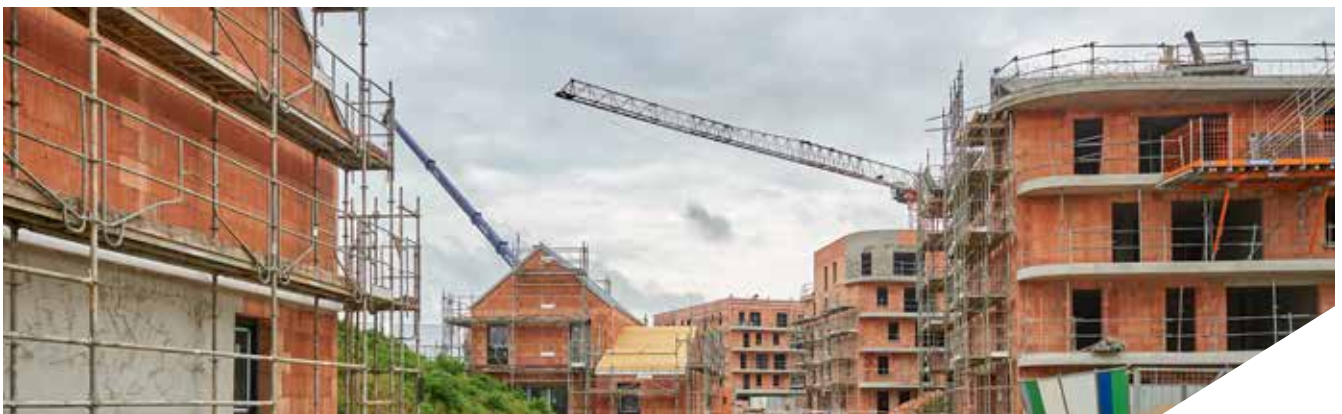
Opération Mycélium, construction de 129 logements collectifs en accession, de 46 maisons et de 44 logements sociaux, Moissy-Cramayel (77).
