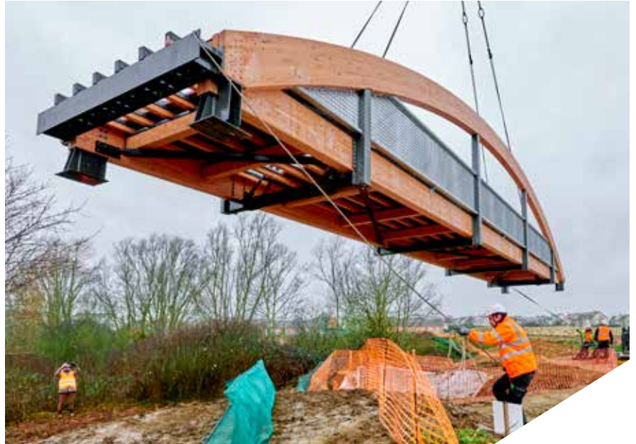
Écoquartier de l'Eau Vive phase II, pose de la passerelle. Lieusaint (77).
